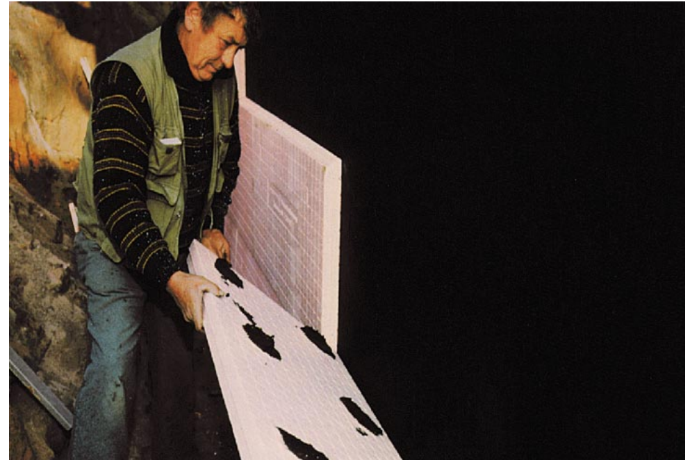
Abb. 7: Ansetzen der Perimeterdämmplatten
