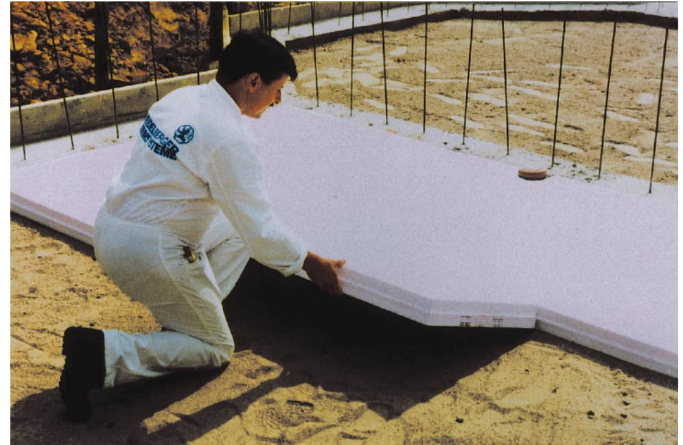
Abb. 8: Auslegen der Styropor-Perimeter-Dämmplatten auf der Sauberschicht
